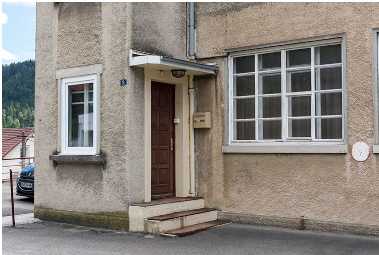
Façade nord : entrée rue Pasteur.
