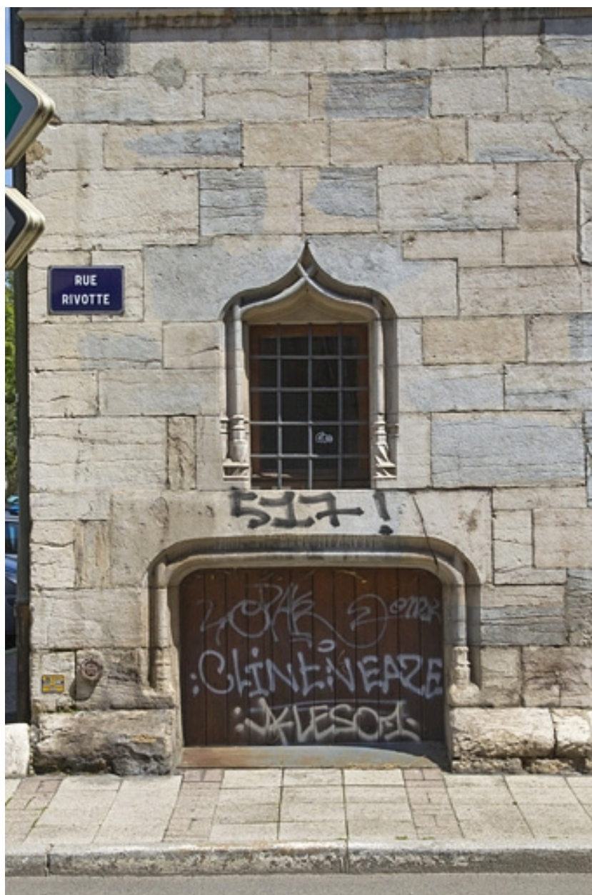
Façade antérieure, vue de l'entrée de cave.
