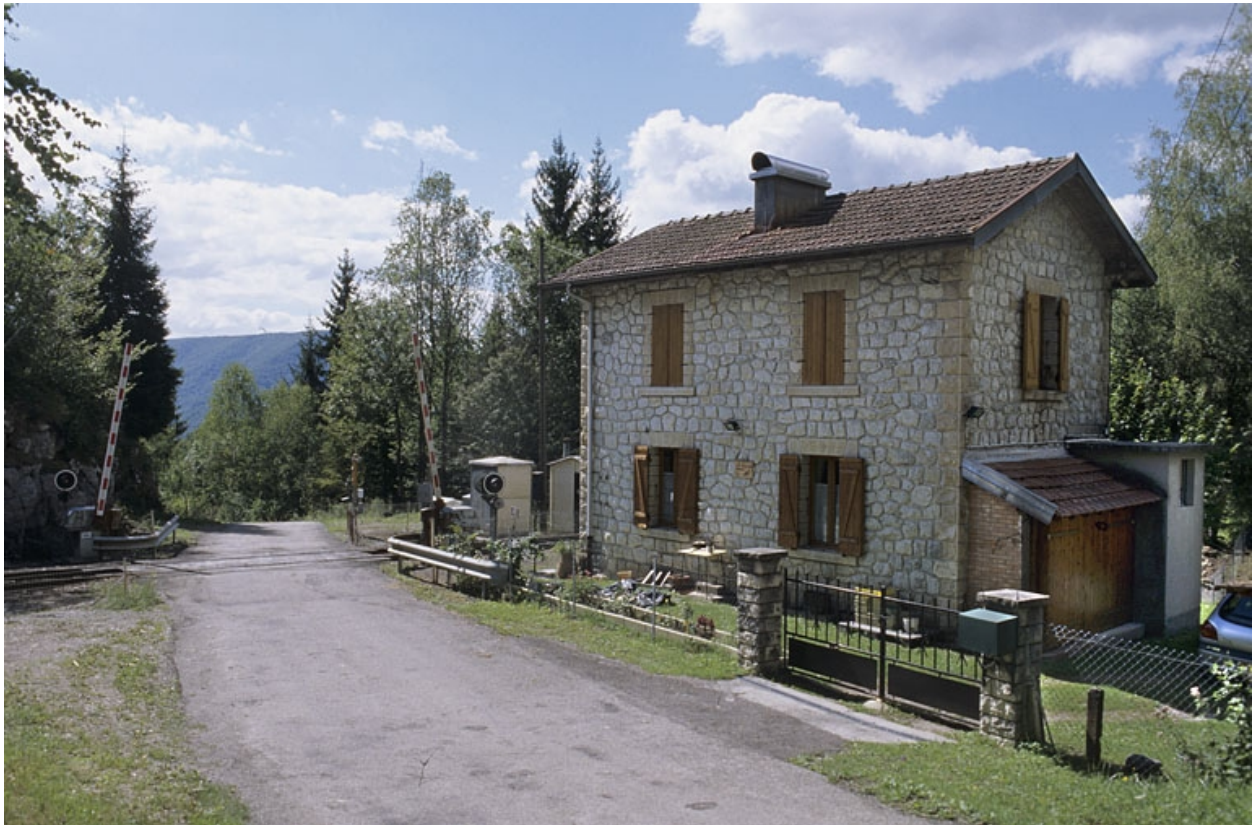
Façades antérieure et latérale droite.
