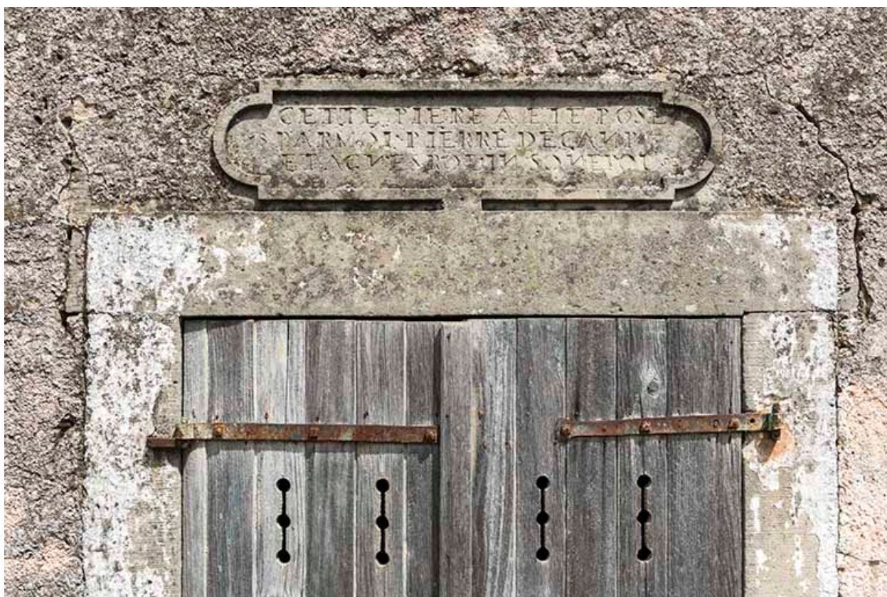
Détail d'inscription de fondation et date portée : 1839.
