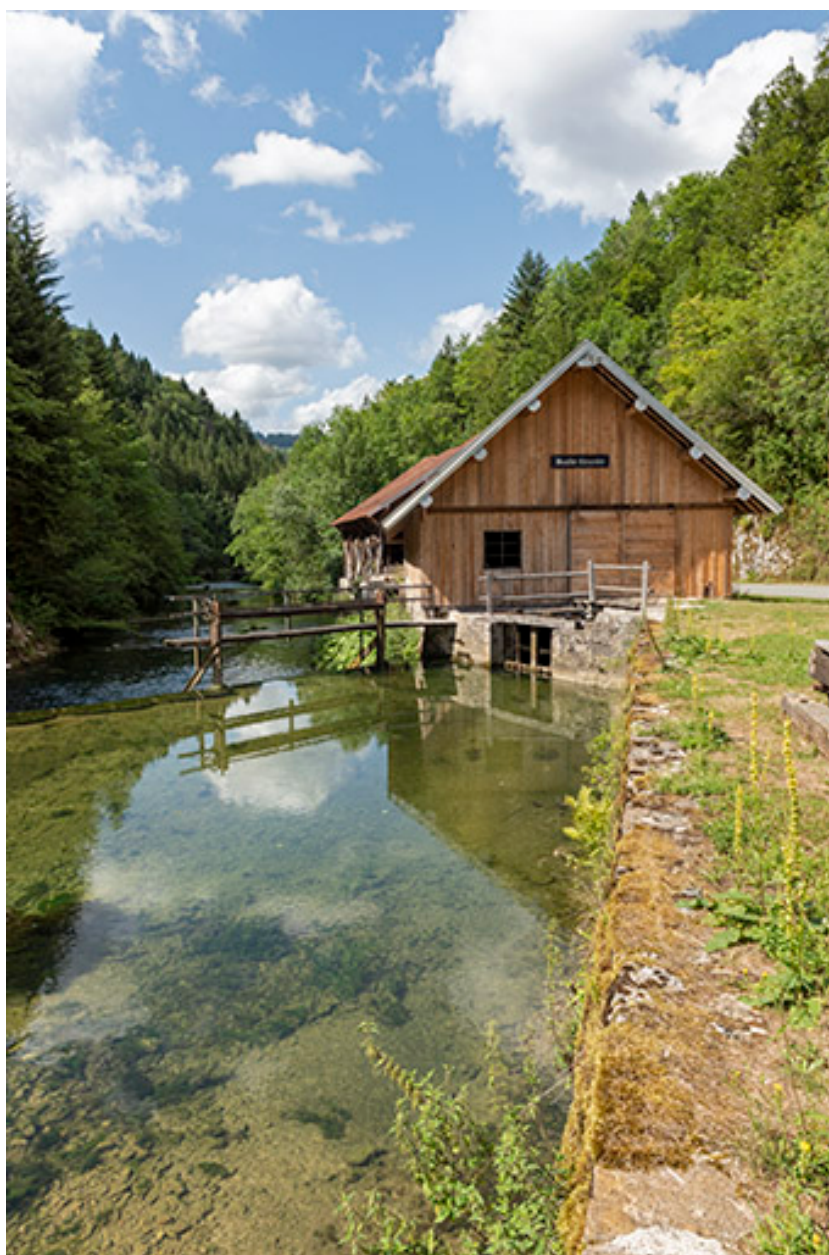
Scierie, depuis l'amont (sud).
