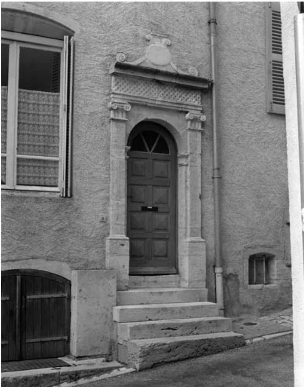
Détail de la porte d'entrée.
