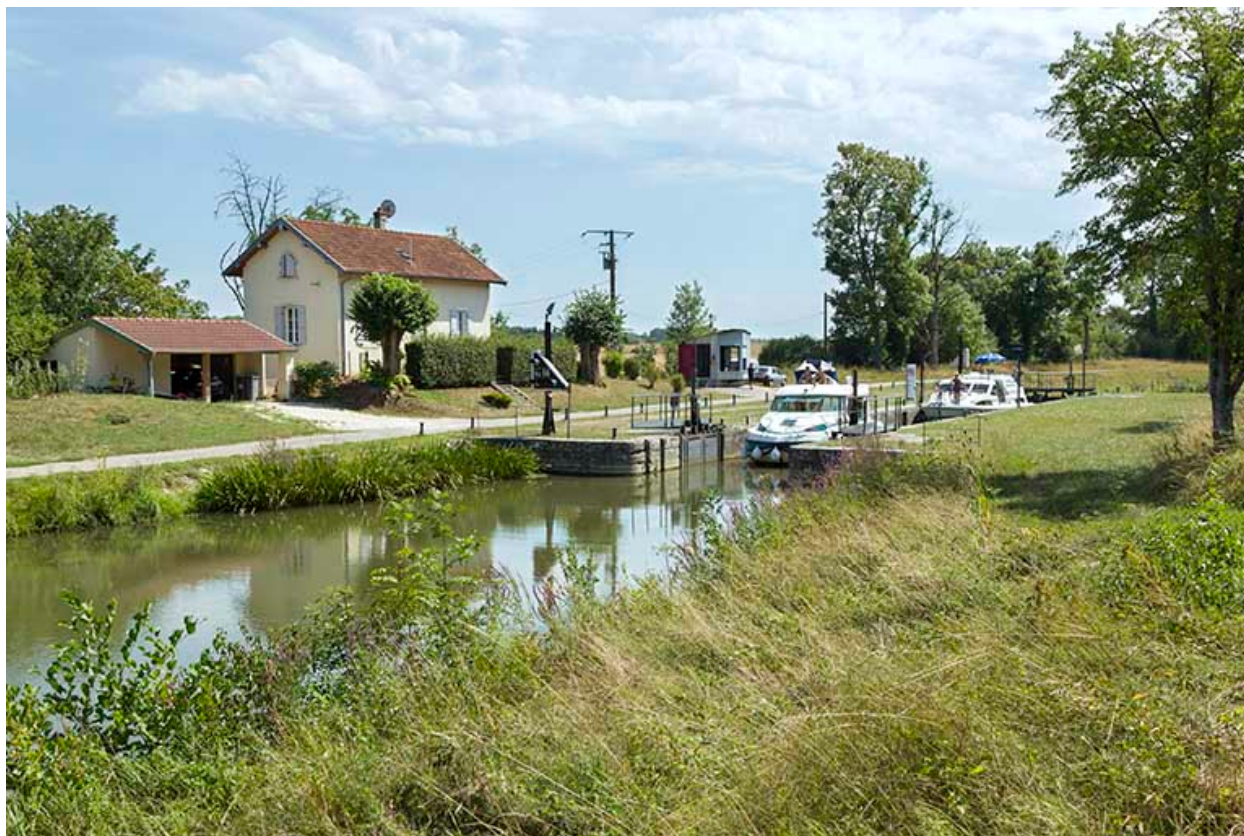
Site d'écluse de Vereux.
