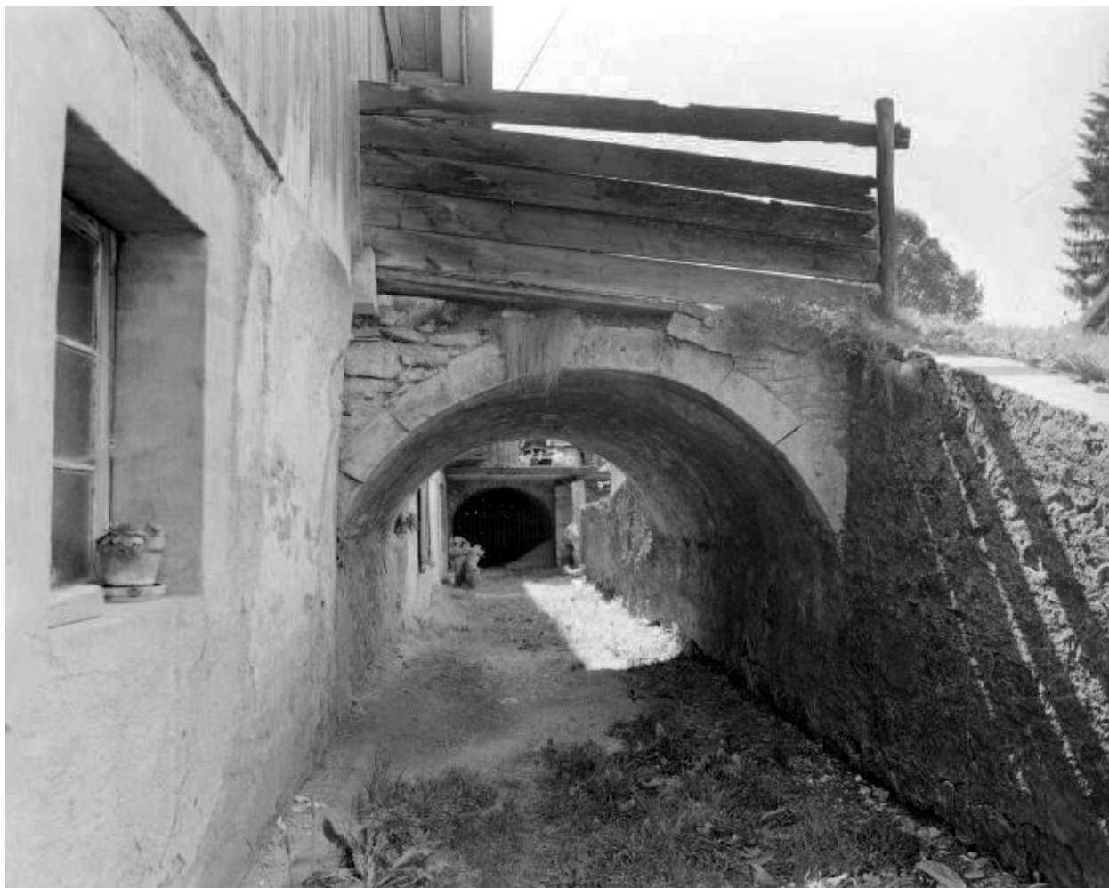
Façade antérieure : ponts de granges.
