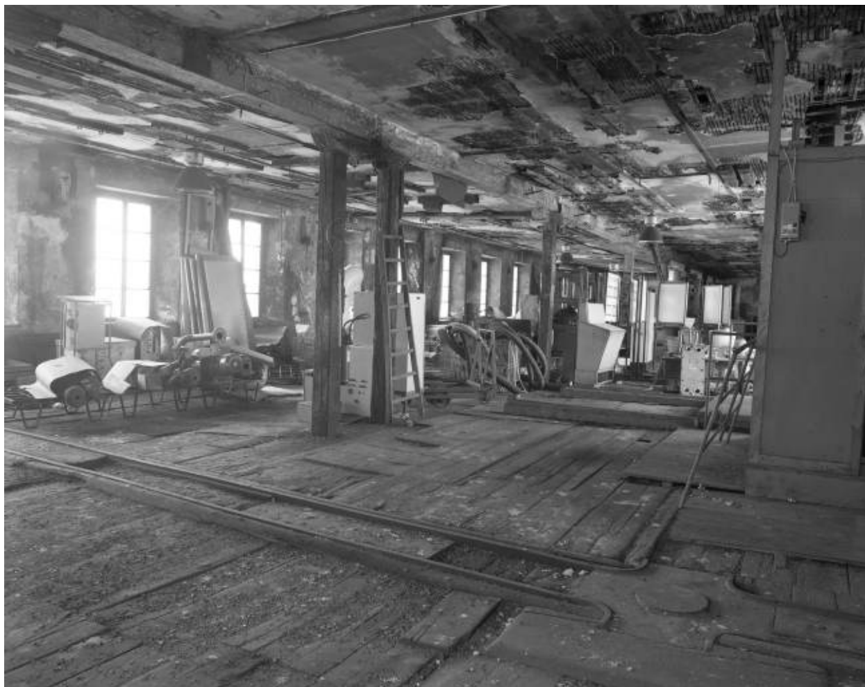
Atelier outillage-entretien mécanique. Premier étage.
