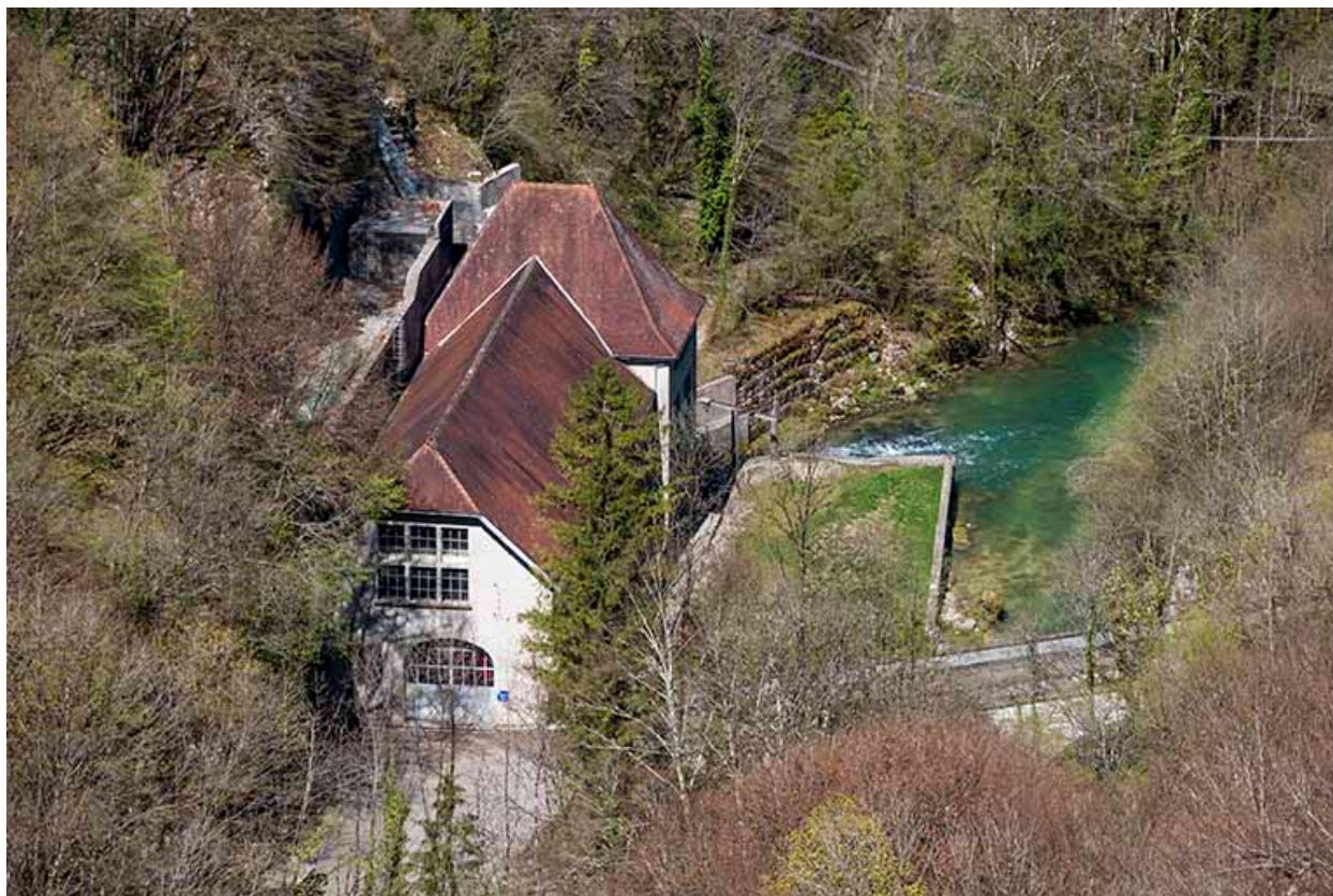
Centrale hydroélectrique de Mouthier, Mouthier-Haute-Pierre.
