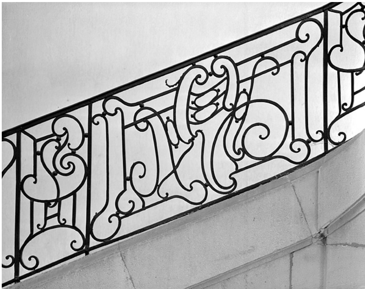
Pilastre et panneau de la 1ère volée.
