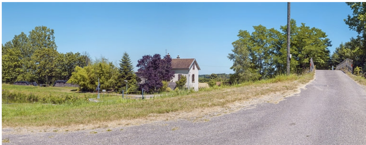
La maison éclusière.
