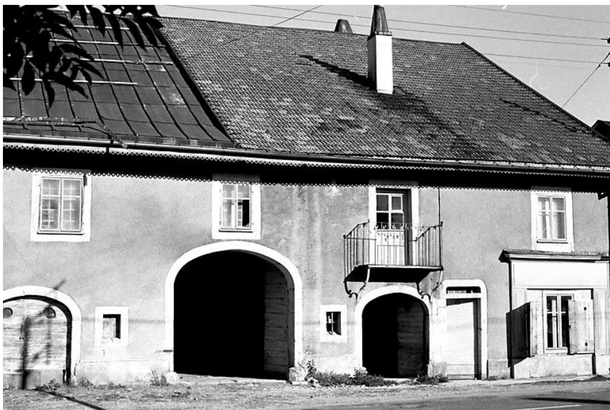
Ferme située 15 rue de la Grande Fontaine : façade antérieure.
