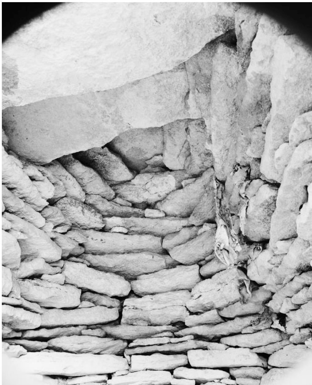
Détail de la voûte.
