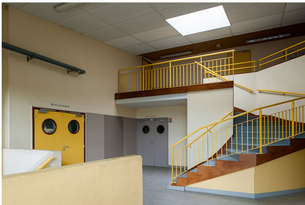
Détail de l'escalier intérieur de l'atelier.
