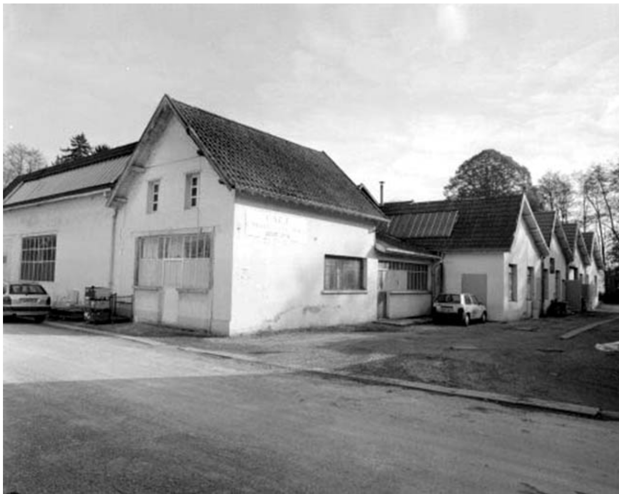
Ateliers de fabrication sud.
