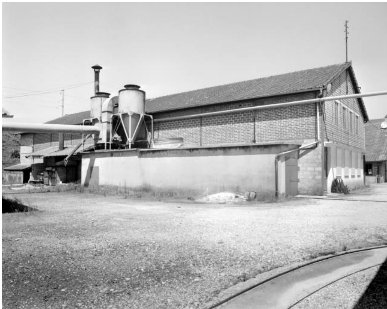
Atelier de fabrication, atelier de conditionnement, bureau.
