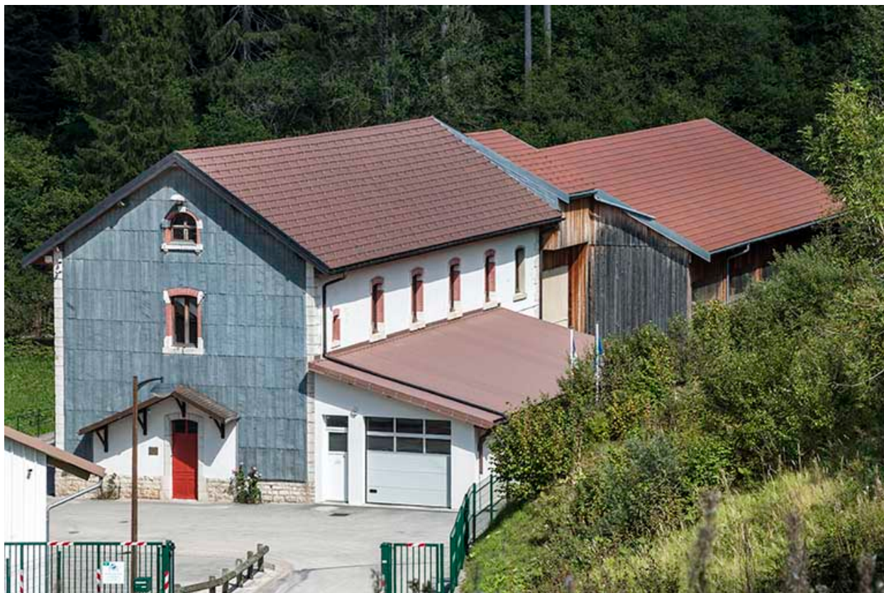
La centrale vue depuis le sud-ouest.
