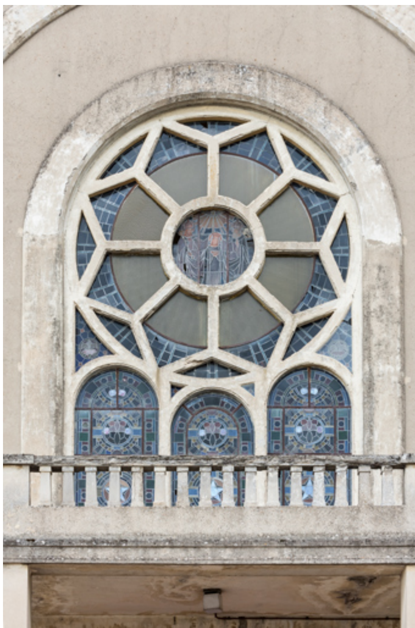
Verrière de la façade ouest. Vue extérieure.
