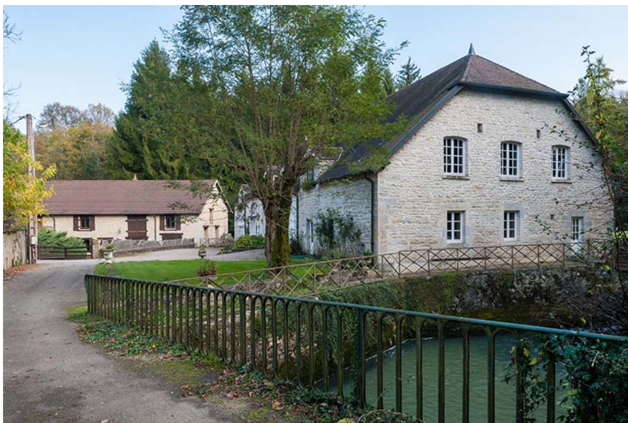
Vue d'ensemble depuis l'ouest.
