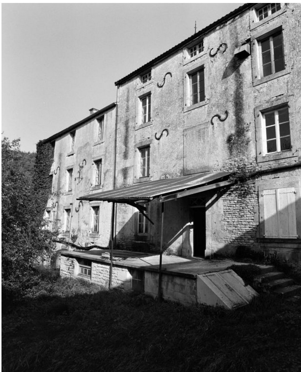
Les bâtiments principaux. Elévations postérieures.
