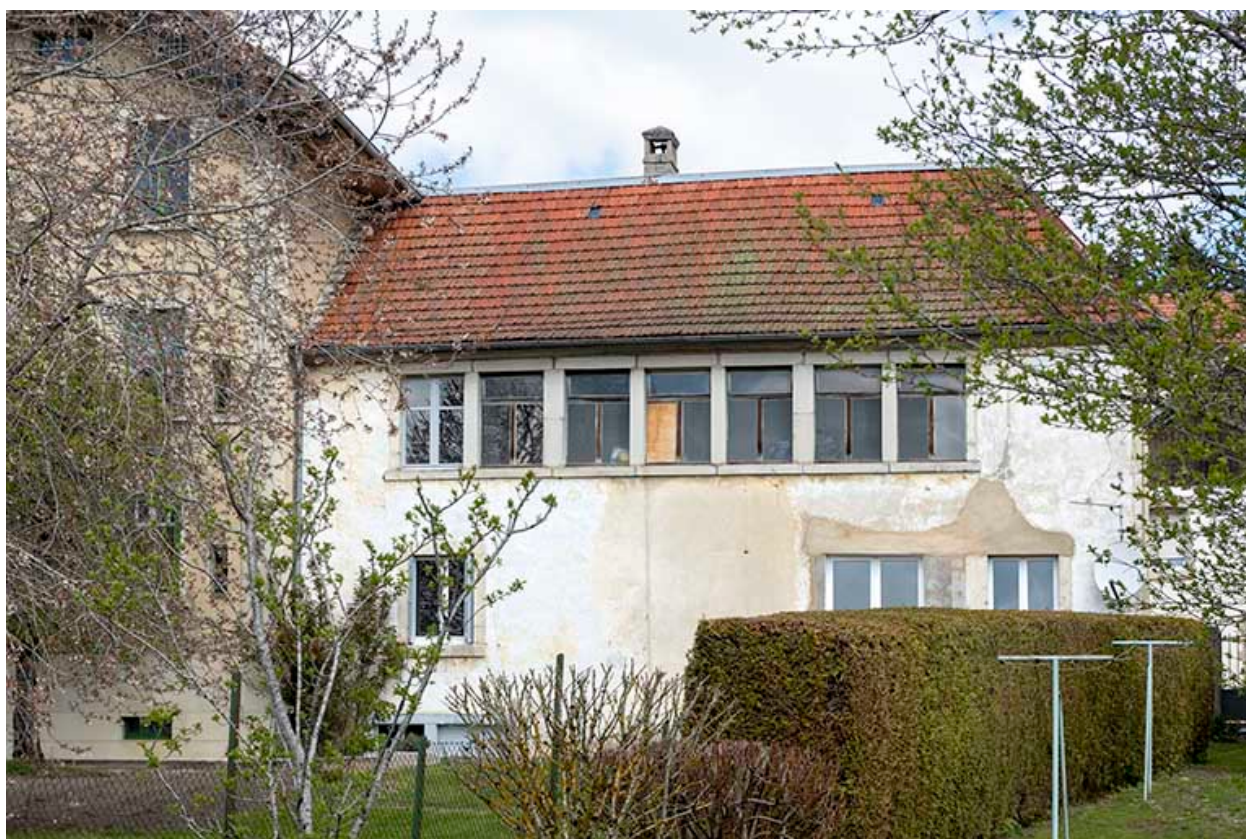
Façade postérieure de l'atelier.
