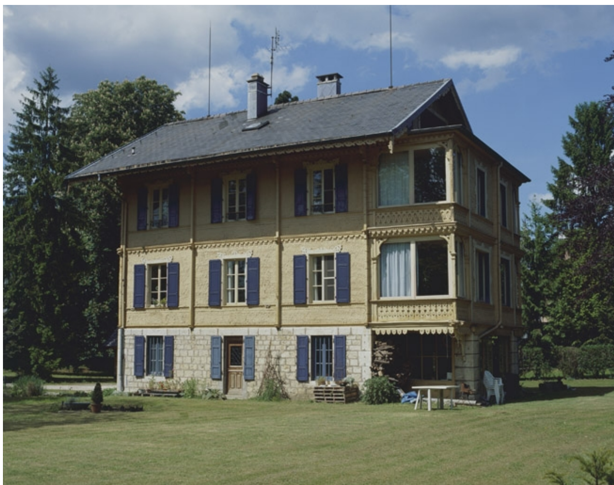
Chalet. Façade sud.
