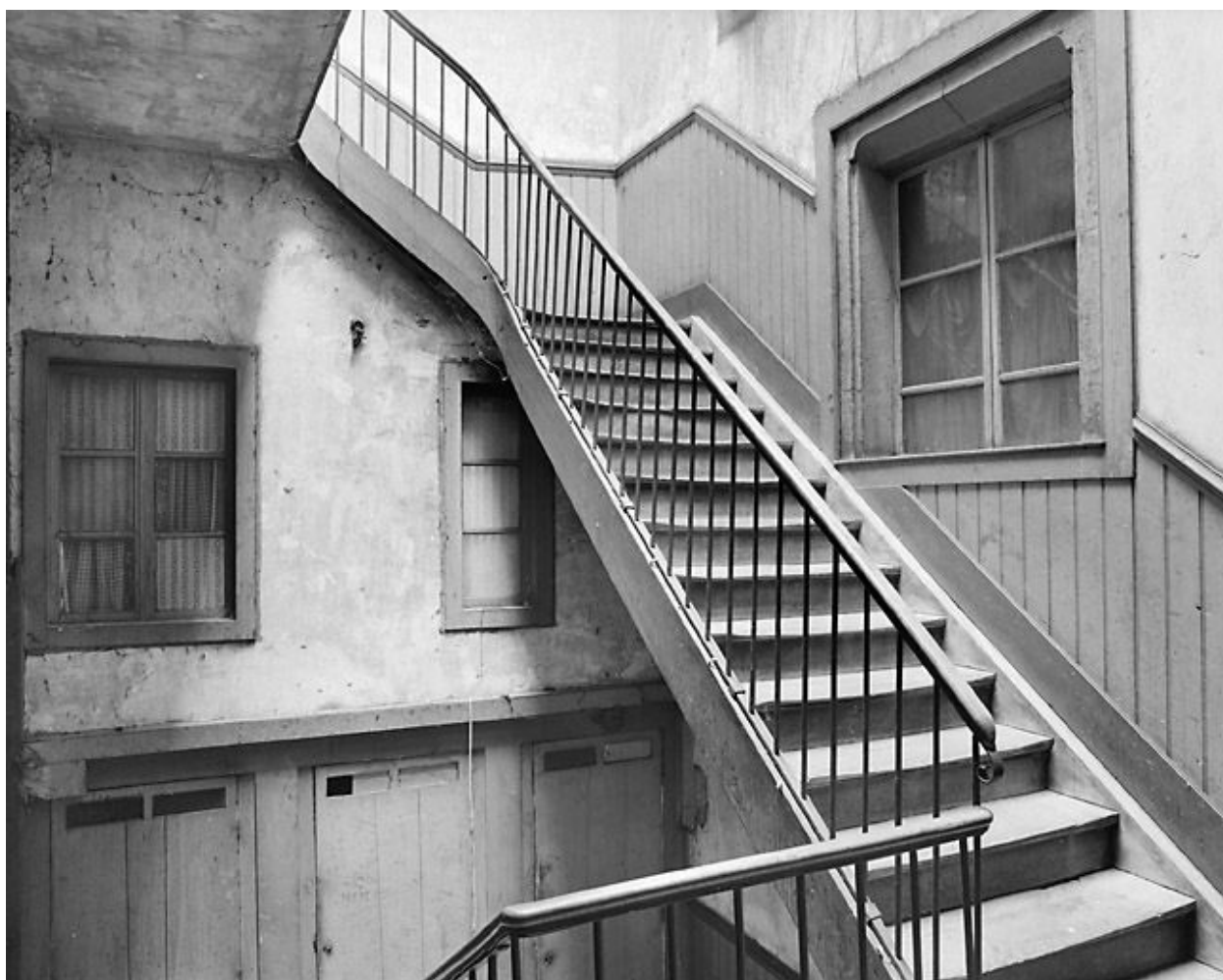
Escalier depuis le palier du premier étage.
