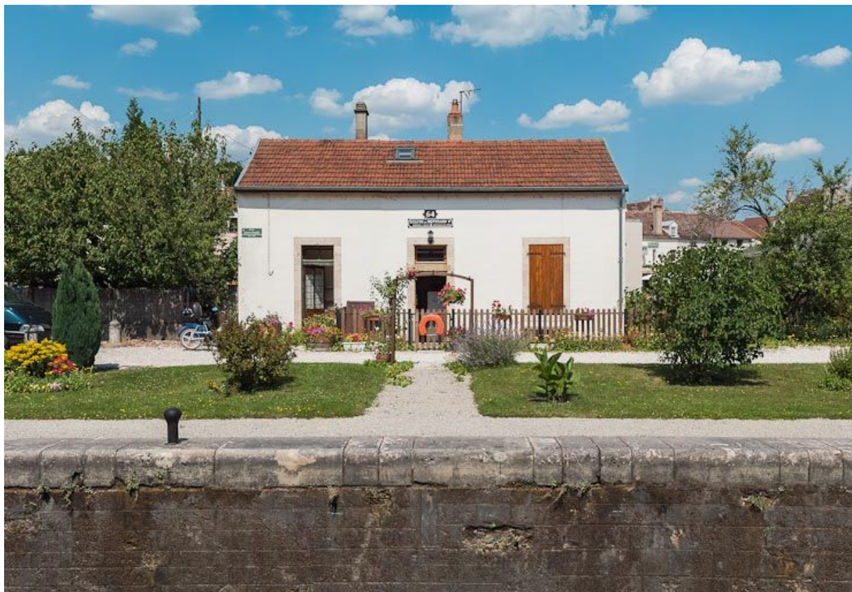
La maison éclusière vue de face.
