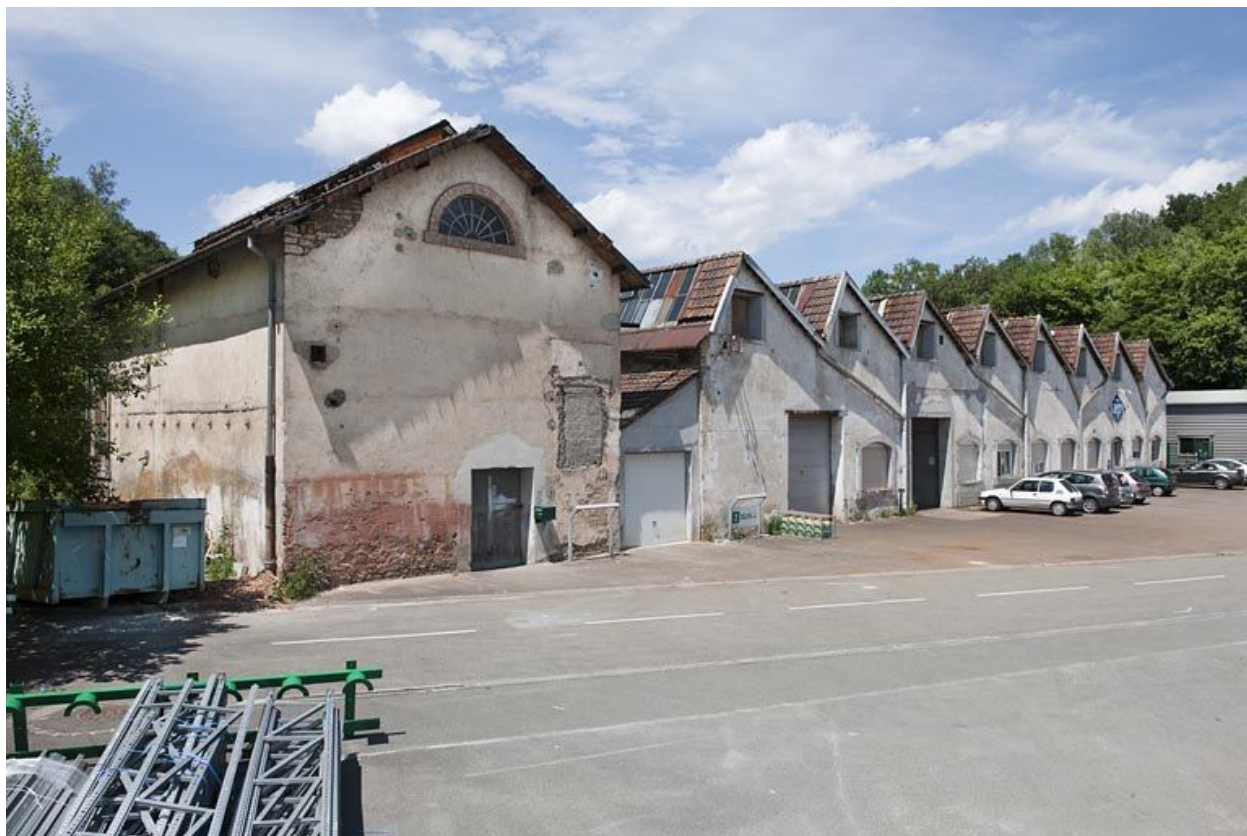
Atelier de fabrication des pompes. Mur-pignons est.
