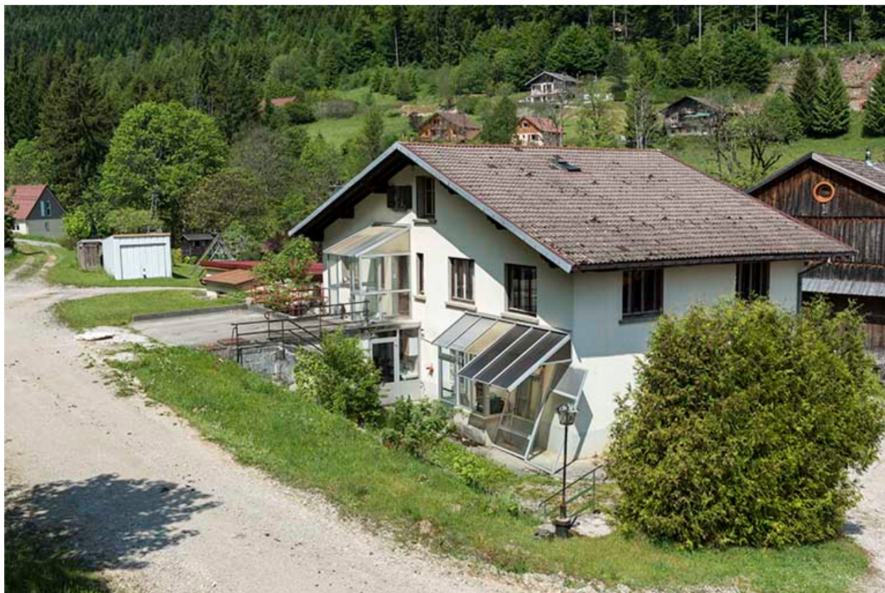
Façades postérieure et latérale gauche.
