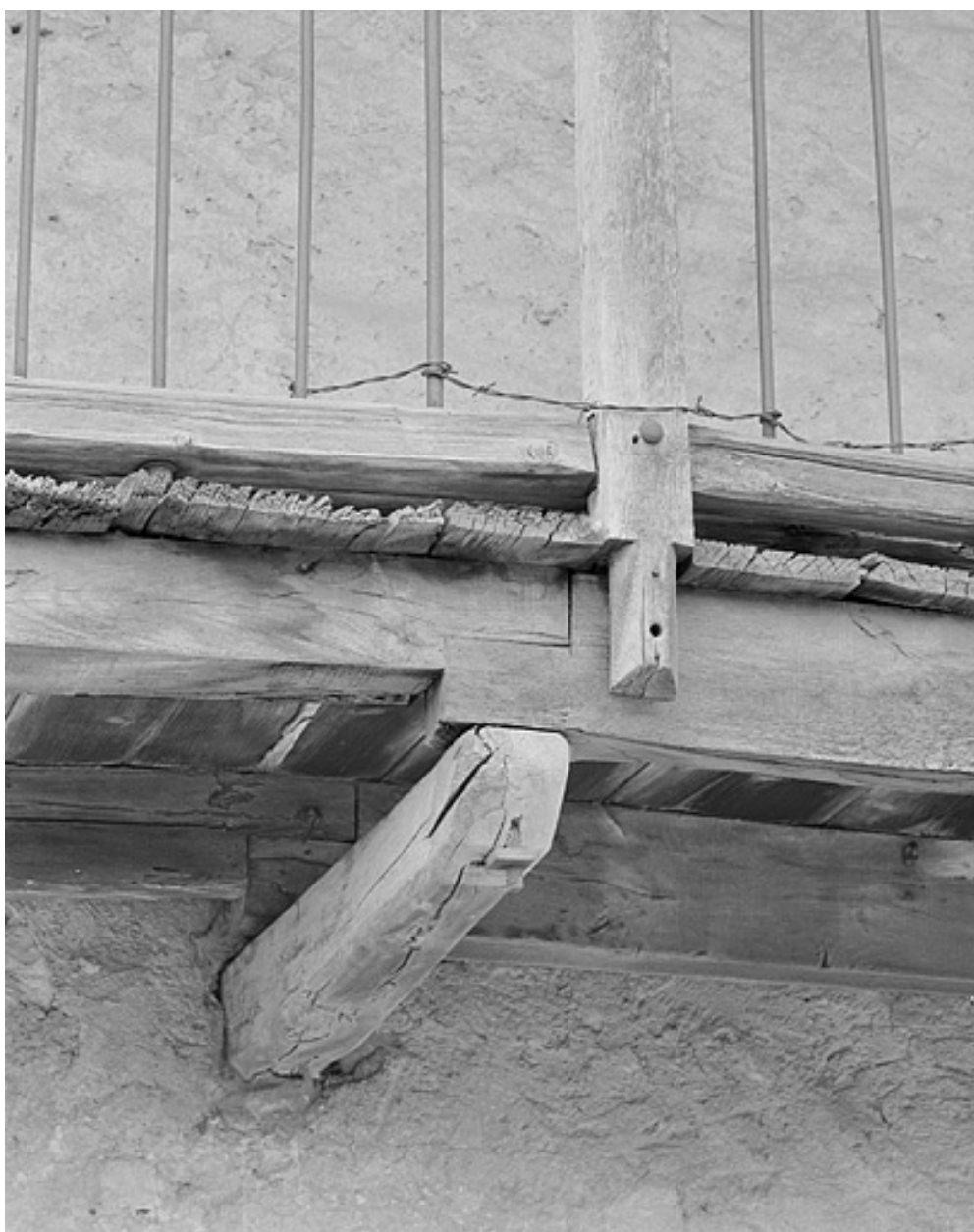
Détail du balcon de l'étage.
