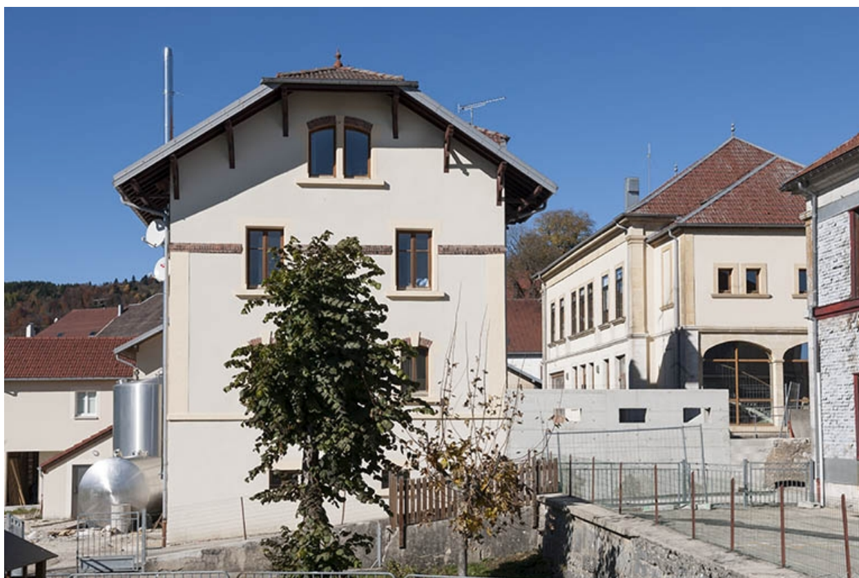
Vue depuis le sud-est.
