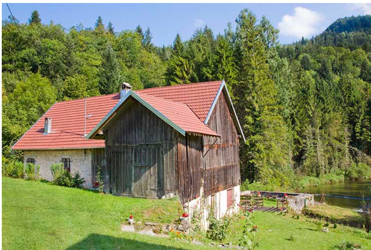
Scierie : façades antérieure et latérale droite.
