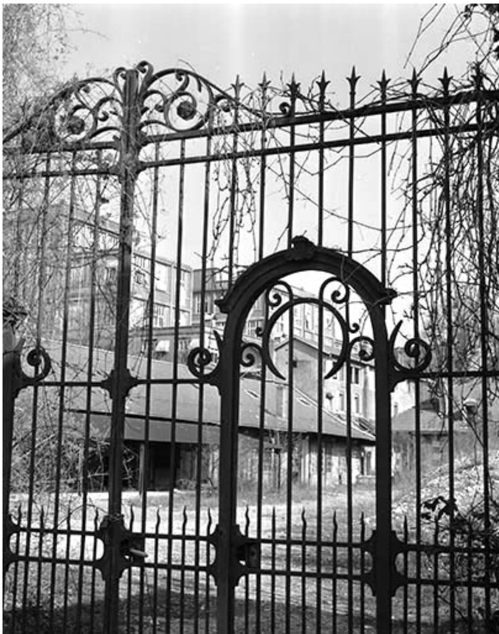
Détail de la grille d'entrée.
