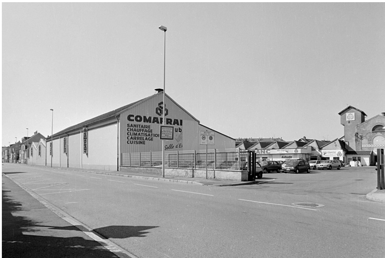
Vue de l'entrée depuis l'avenue Jean Jaurès.
