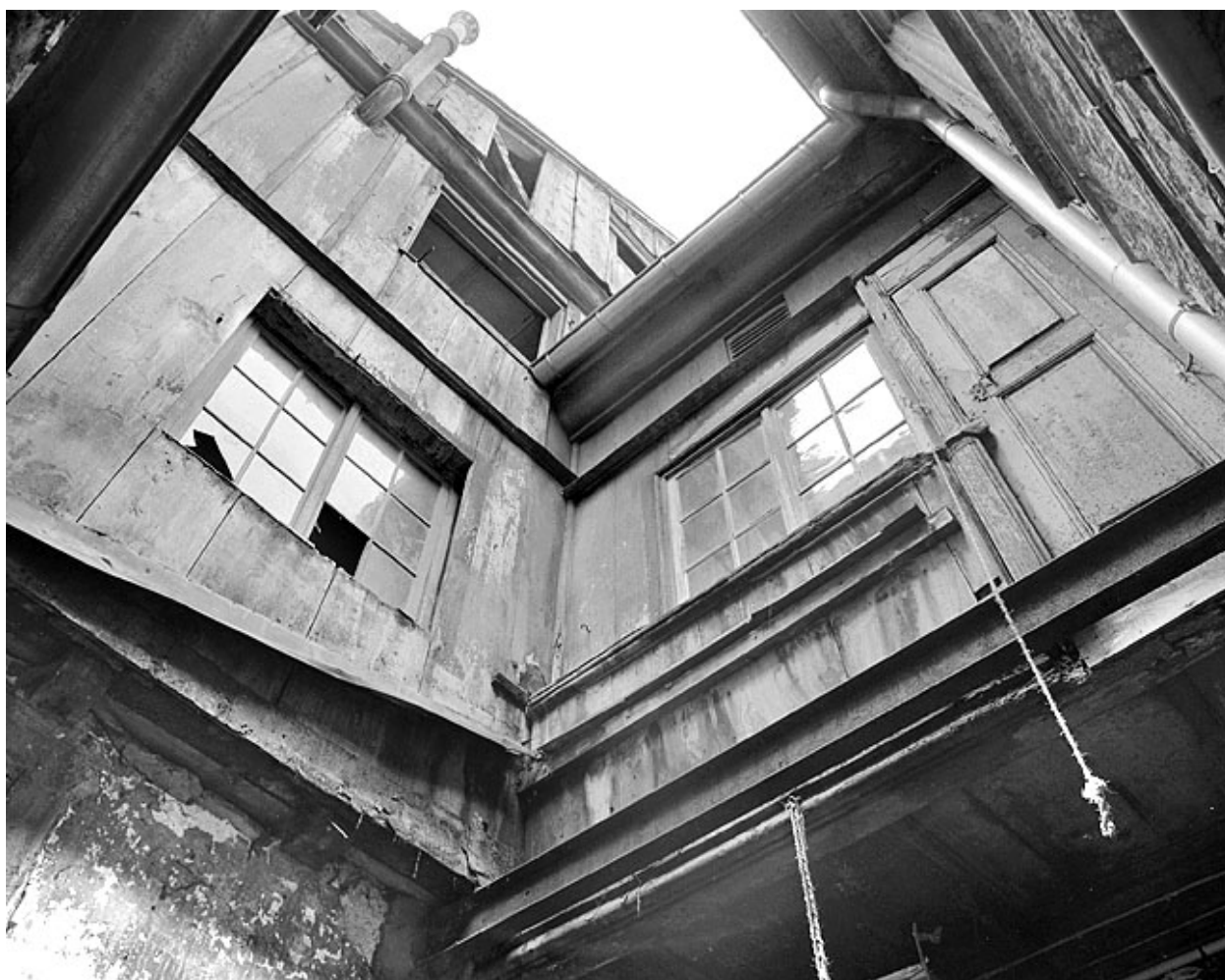
Cour. A gauche, cage d'escalier accolée au premier corps de bâtiment ; à droite, galerie de liaison.
