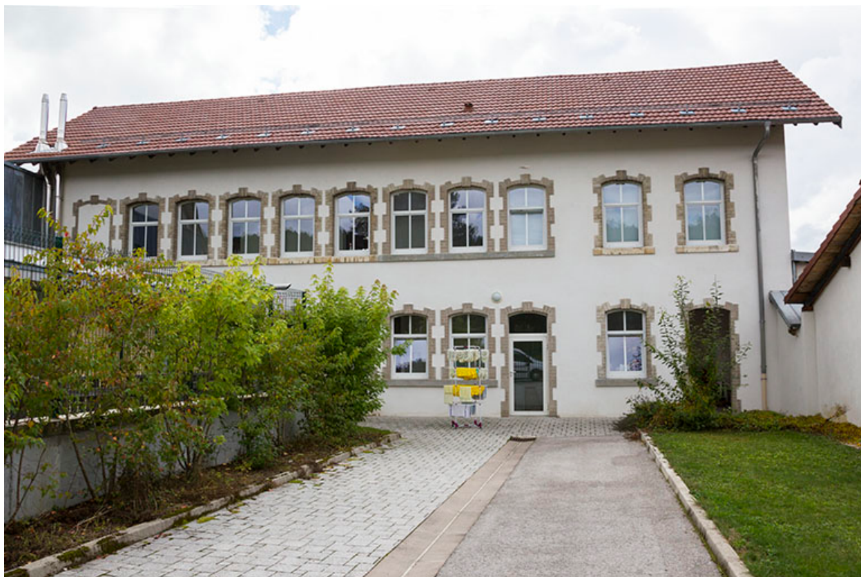
Atelier d'origine : façade orientale.
