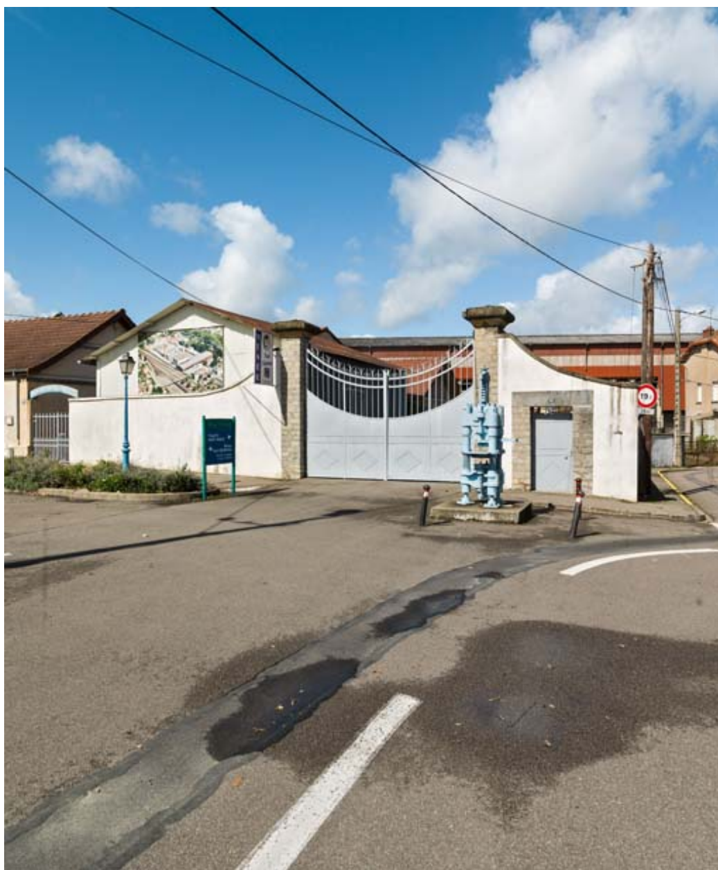
Entrée du site.
