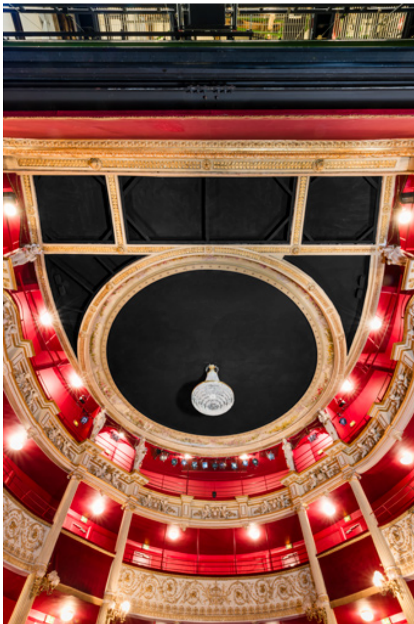
Vue d'ensemble du plafond.
