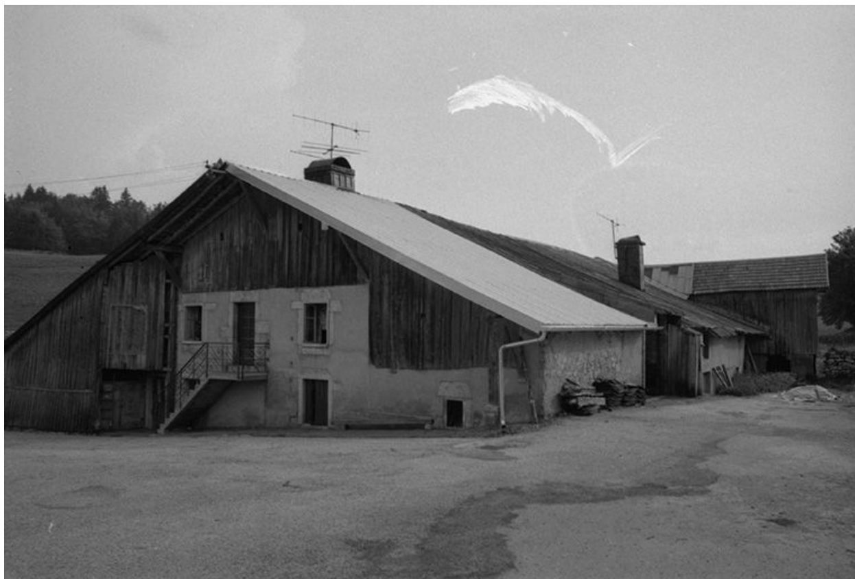
Façades antérieure et latérale droite.
