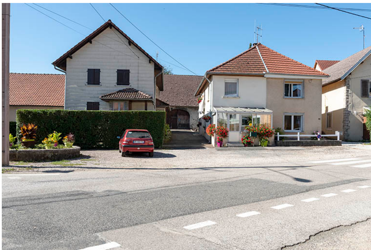
Vue d'ensemble, depuis la rue (au nord).
