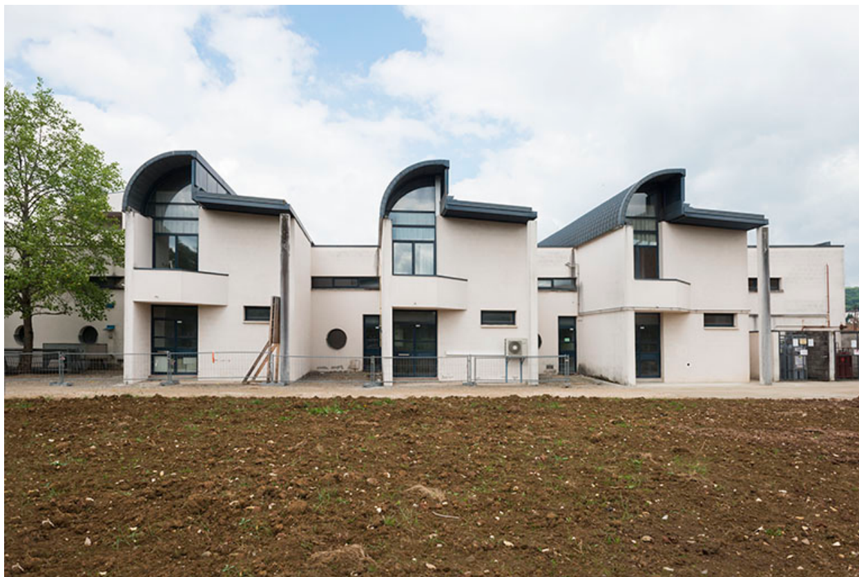
Façades postérieures sud-est des ateliers.
