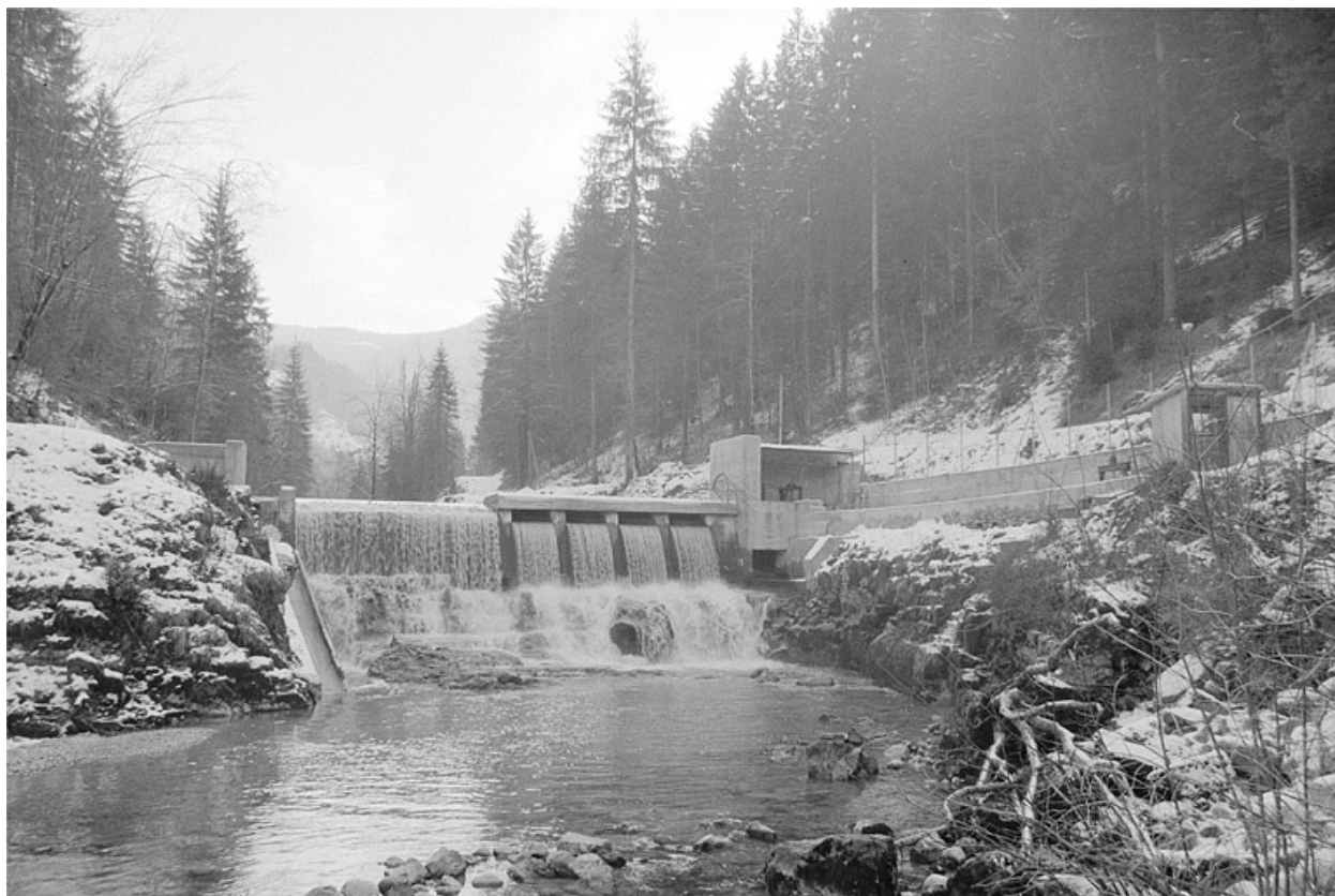
Barrage et prise d'eau.
