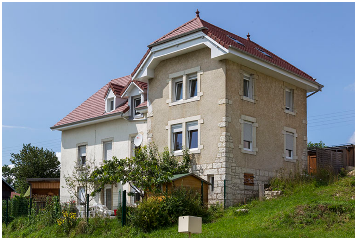
Façades postérieure et latérale gauche.
