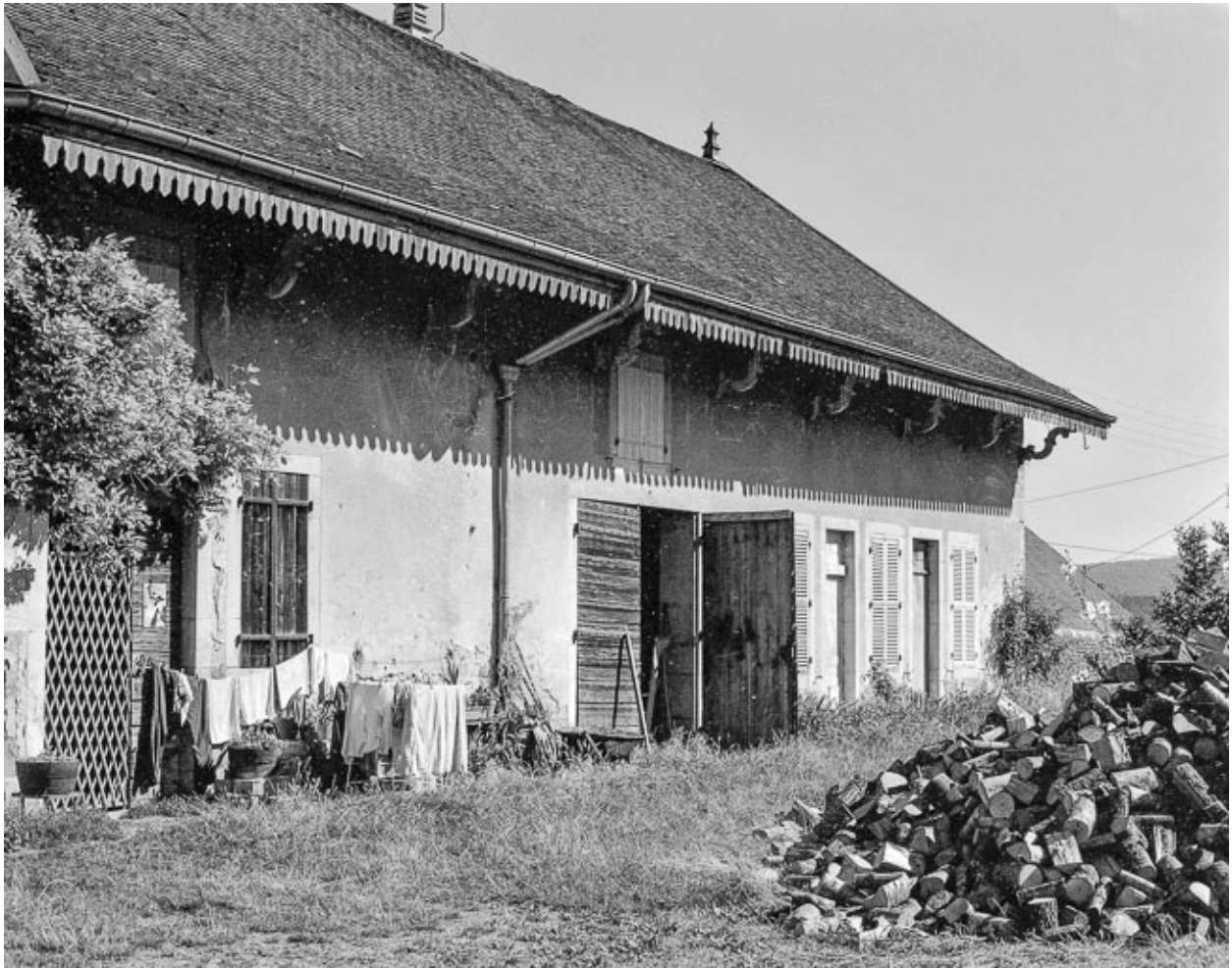
Maison cadastrée AC 251 ; façade postérieure.
