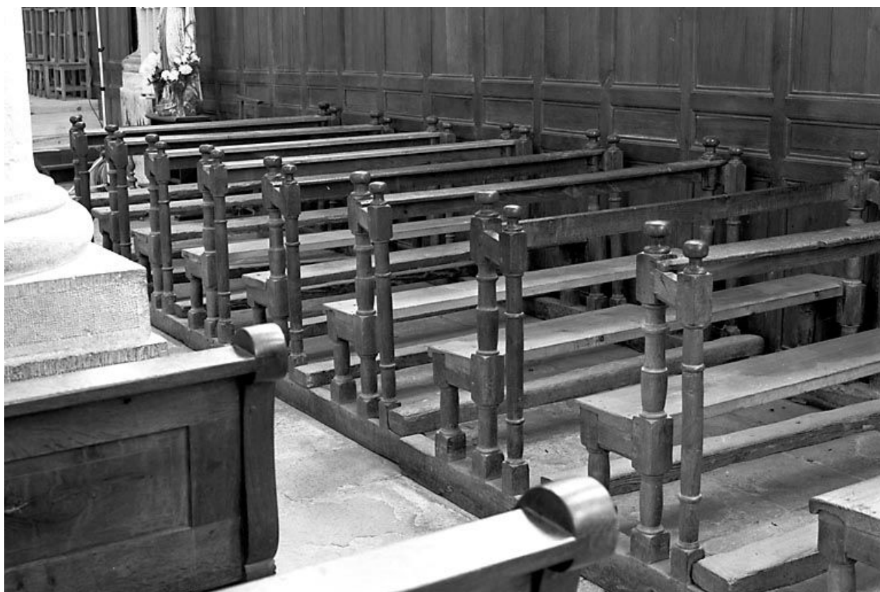
Vue d'ensemble des bancs du bas-côté sud.
