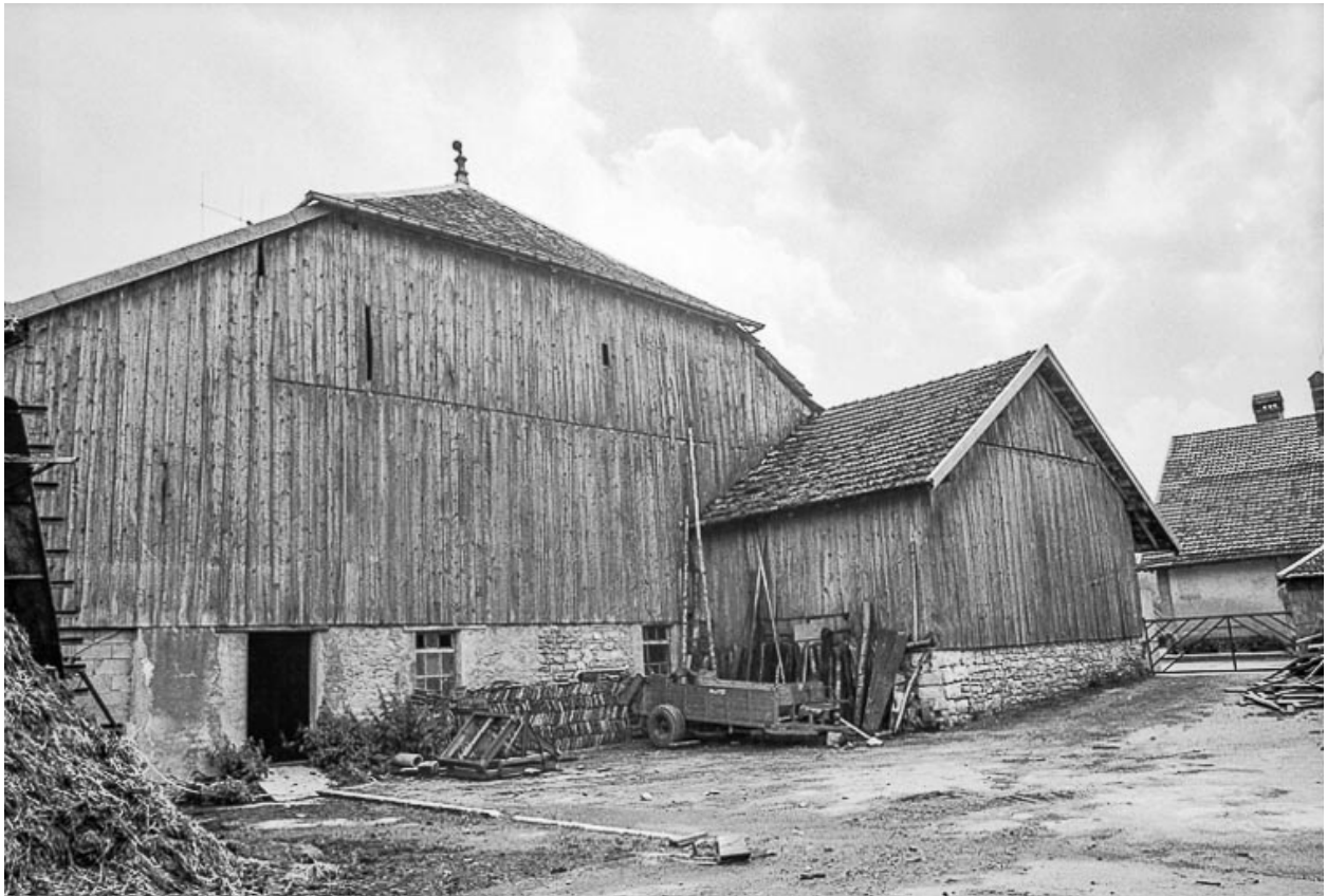
Pignon postérieur de la partie agricole.
