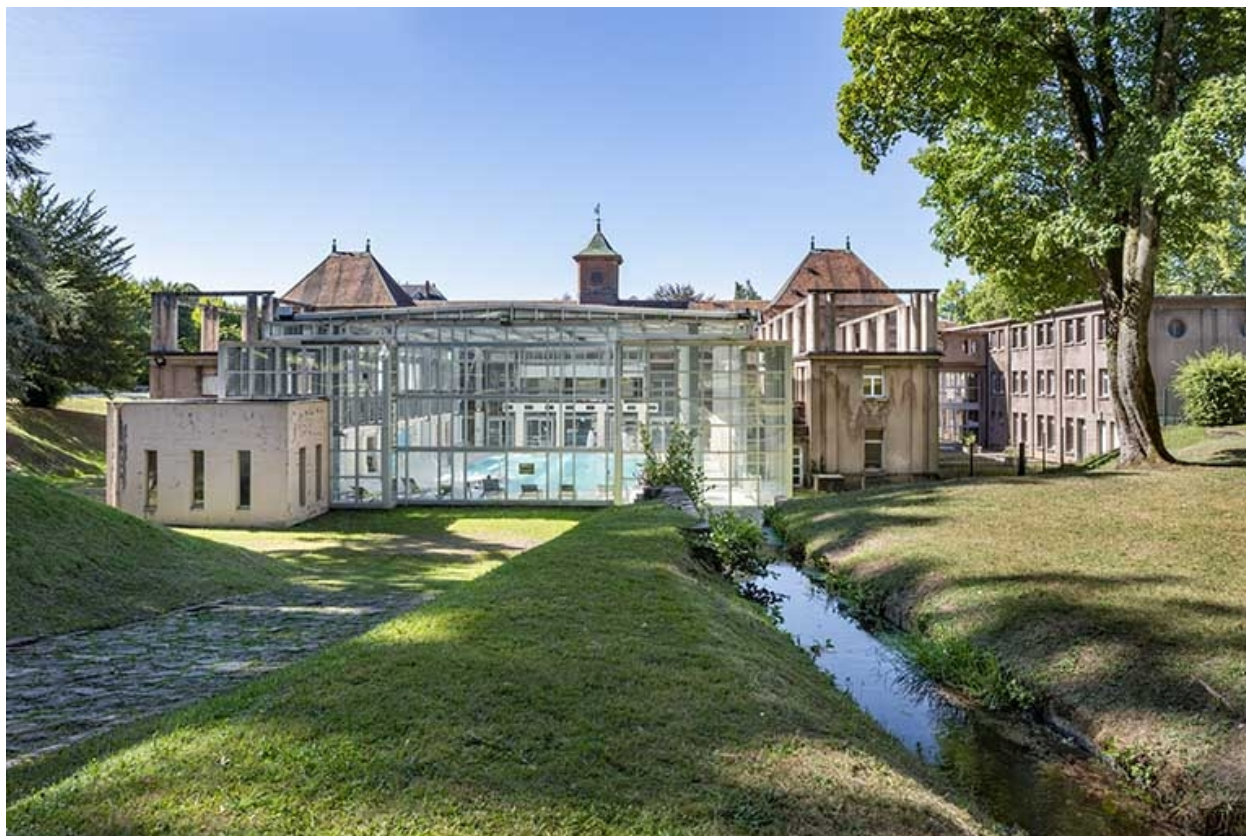
Vue en direction de l'établissement thermal.
