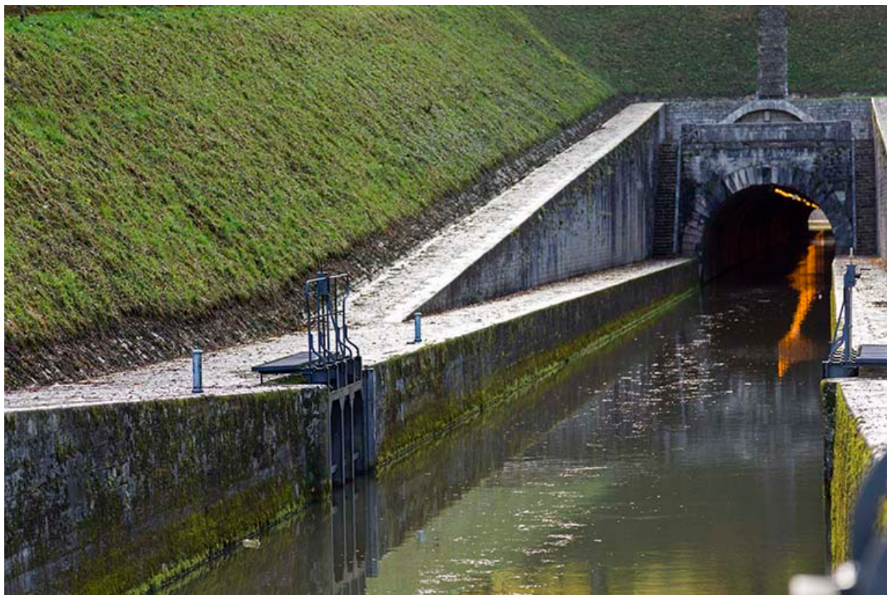
Le tunnel, vue amont.
