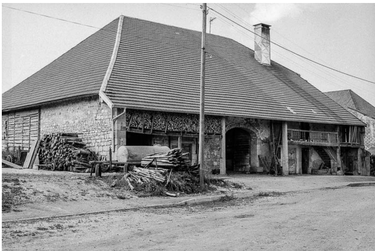
Ferme, cadastrée 1938 F 62 : façade antérieure.
