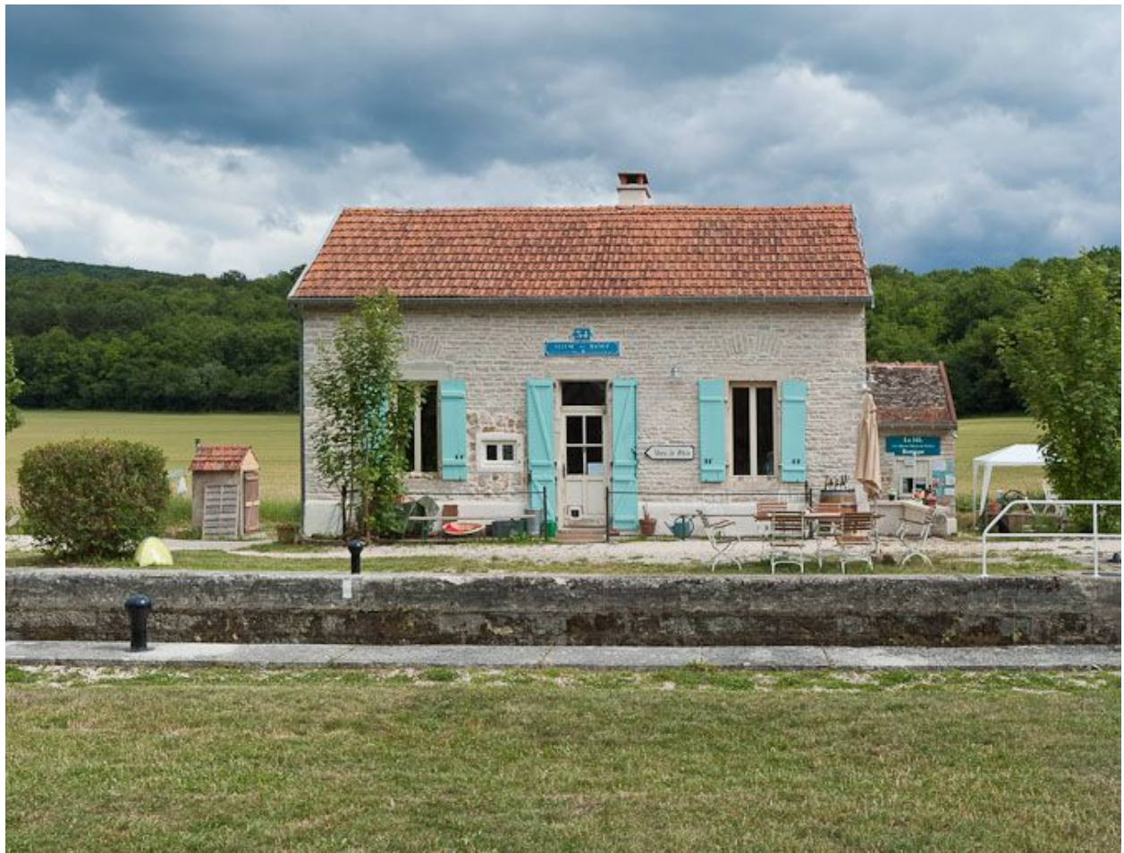
Vue de face de la maison éclusière.
