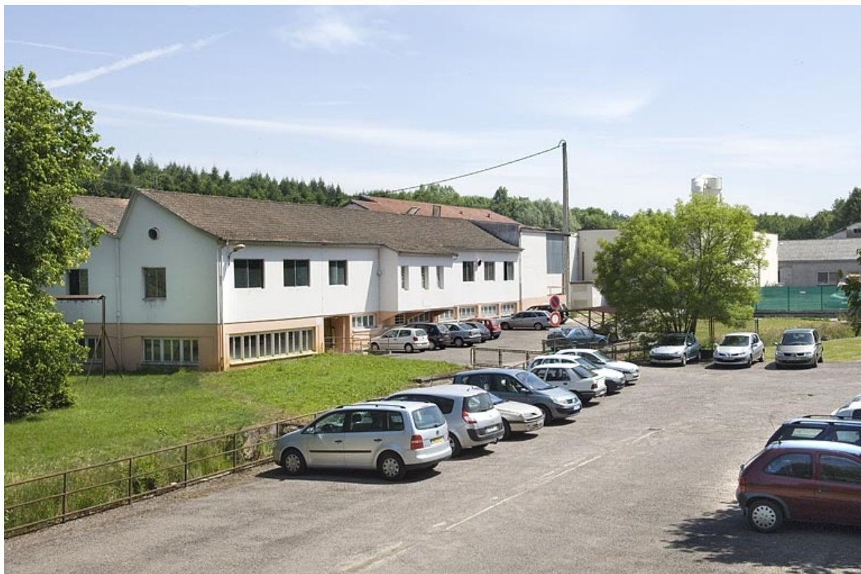
Vue depuis le sud-ouest.
