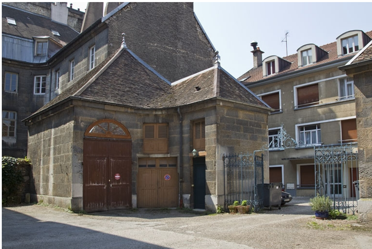
Détail de la remise gauche.
